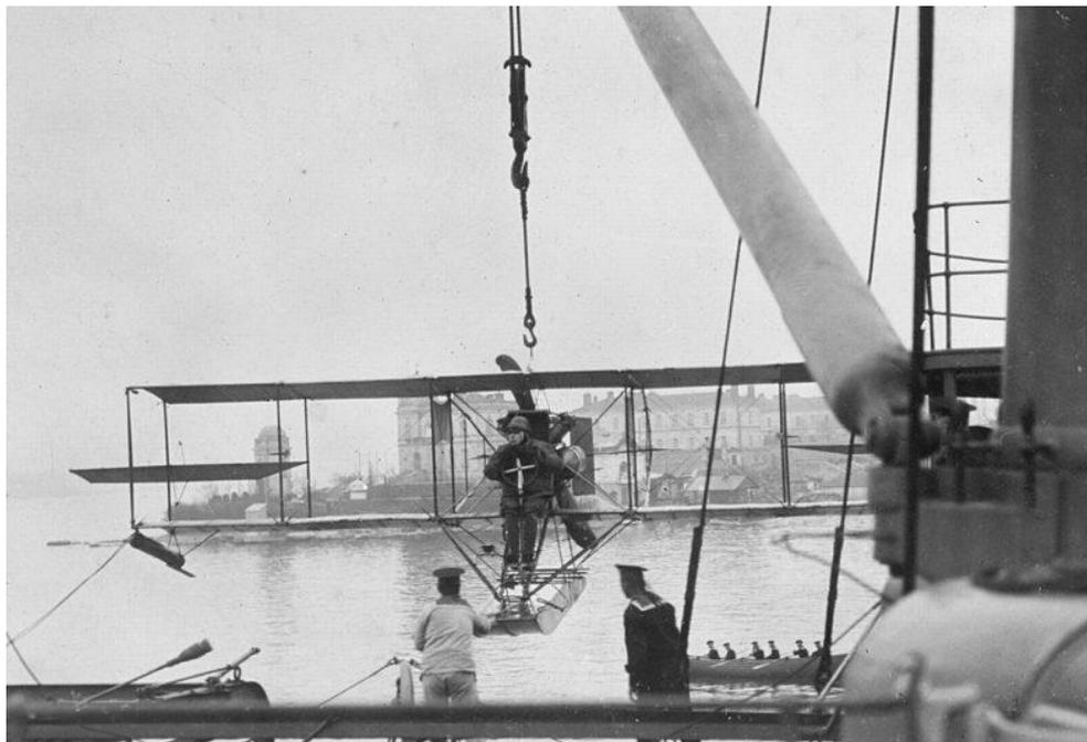
Фото 3 и 4. Подъем аэроплана Кертиса на палубу крейсера "Кагул", январь 1914 г.
