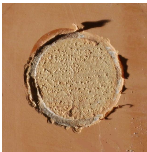
Фото 4. Отрыв TERRA NOSTRA от PUTZGRUND толщина оторванного слоя 260 мкм, адгезия 0,5 МПа
